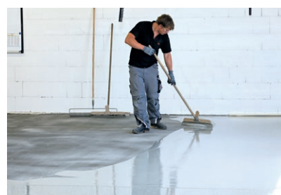
Verteilen mit Rake und Stachelwalze
