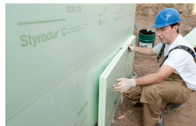
Vollflächige (oberhalb Grundwasserspiegel auch punktuelle) Verklebung der Dämmplatten. Stöße der Platten anschließend verspachteln
