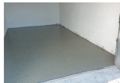
Während des Einbaus egalisiert und entlüftet sich PCI Zemtec Outdoor selbstständig
