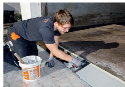
Aufbringen von PCI Aposan zum Überbrücken von Höhenunterschieden bis 50 mm
