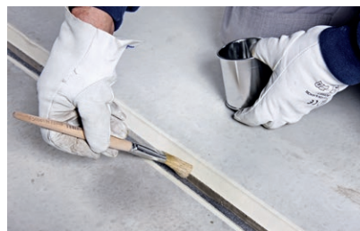
Primern der Fugenflächen und Ablüftzeiten beachten. Auf gleichmäßiges Einbringen des Fugendichtstoffs achten
