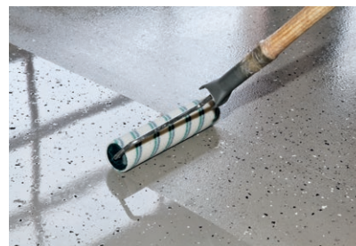
Aufbringen einer UV-stabilen Kopfversiegelung, z. B. PCI Finopur
