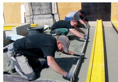
PCI Nanocret R4 PCC auf einer Brücke nach ZTV-ING
