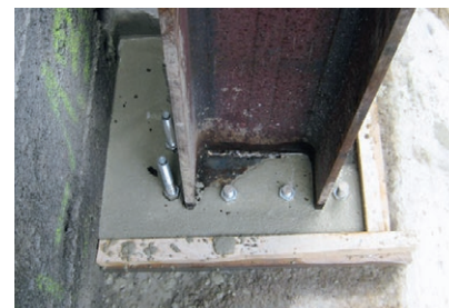
Verguss einer Stütze mit PCI Repaflow
