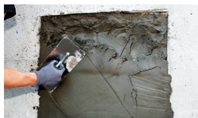
Den hochfesten Reparaturmörtel, z. B. PCI Nanocret R4 PCC, satt und hohlraumfrei händisch oder maschinell auftragen
