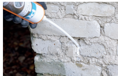
Injektion einer wasserabweisenden Horizontalsperre mit PCI Barra Creme
