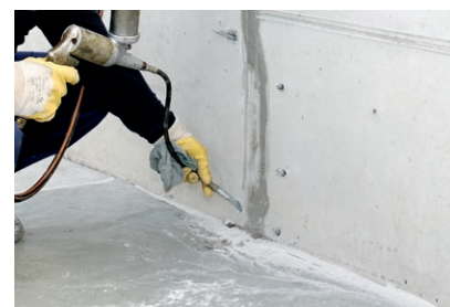
Das Injektionsharz von unten nach oben bis zur vollständigen Sättigung injizieren
