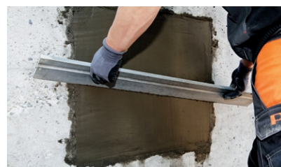
Die Reparaturflächen bündig abziehen und nach kurzer Wartezeit glätten bzw. abfilzen
