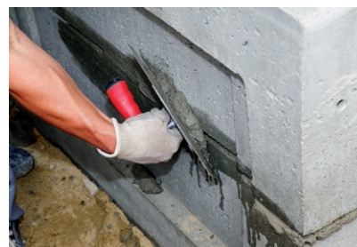
Schließen von Fugen und Angarnieren von Ecken und Kanten mit PCI Nanocret R2
