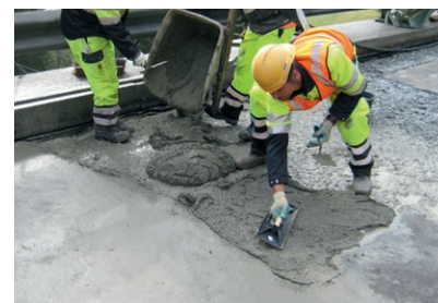
Standfester Bodenausgleich eines Betonausbruchs mit PCI Repafast Tixo
