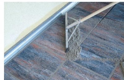
Einbringen des wasserdurchlässigen Pflaster- fugenmörtels PCI Pavifix 1K Extra auf der vorgenässen Natursteinfläche
