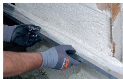
Abziehen des Sanierputzmörtels PCI Saniment 2 in 1
