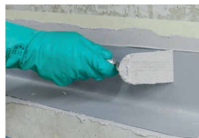
Das Abdichtungsband PCI Pecitape 3000 sorgfältig andrücken und mit einer Kelle glattstreichen
