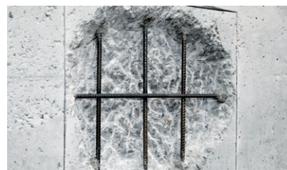
Die Bewehrungsstäbe von Rost und Altanstrichen befreien
