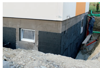
Übergang einer Schwarzabdichtung mit PCI-Reaktivabdichtung über die Geländeoberkante
