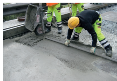
Standfester Ausgleich einer Bodenfläche aus Beton mit PCI Repafast Tixo
