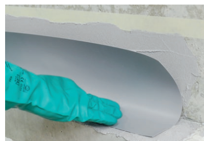
Den Epoxi-Baukleber PCI Barrafix EP gleichmäßig auftragen und das Abdichtungsband PCI Pecitape 3000 einlegen
