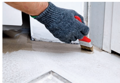
Händischer Auftrag der mattierenden Kopfversiegelung PCI Finopur
