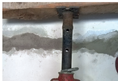
Schwundfreies Ausfüllen von Spalten mit PCI Repaflow USM
