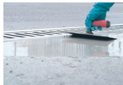
Anarbeiten an eine Rinne mit dem Epoxi-Vergussmörtel PCI Repafast EP Plus
