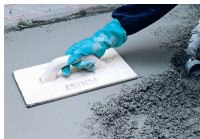
Der PCI Novoment Schnellestrich muss frisch in frisch auf die Haftbrücke aufgebracht werden
