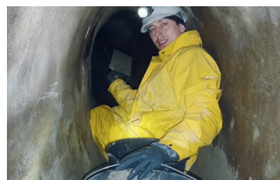
Aufbringen der sulfatbeständigen Dichtschlämme PCI Barraseal im Bereich von Abwässern
