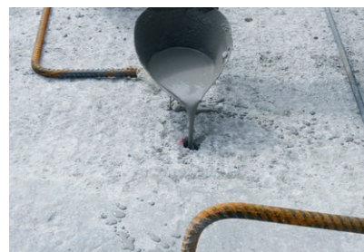
Verfüllen von Bohrlöchern mit PCI Polyfix 5 Min.
