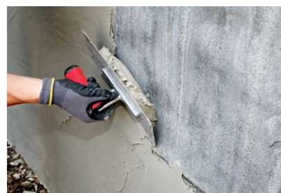
Aufbringen des faserverstärkten Feinspachtels PCI Nanocret FC
