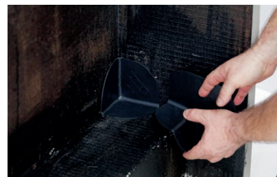
Kritische Ecken sicher abdichten mit PVC-Formteilen PCI Pecithene I 90° und PCI Pecithene A 90°
