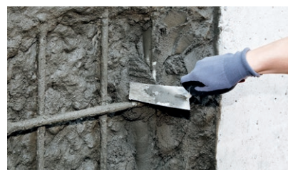
Kontaktschicht mit der ersten Lage Reparaturmörtel aufstreichen oder mit der Traufel aufkratzen
