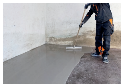
Angemischtes PCI Zemtec 1K gleichmäßig verteilen und anschließend mit einer Stachelwalze entlüften
