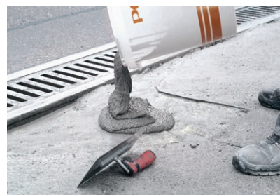
Fließfähiger Ausgleich einer Bodenfläche aus Beton mit PCI Repafast Fluid
