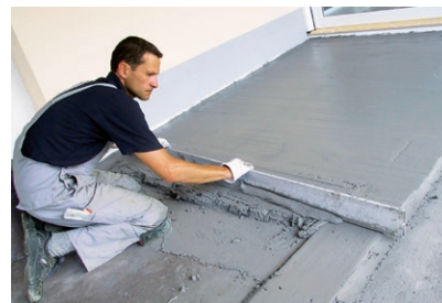
Mit Zusatzmitteln wie PCI Estrifix und PCI Dichtungsmörtel werden Verarbeitung und Eigenschaften von zementären Estrichen optimiert
