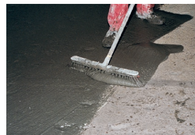
Aufbringen einer Mörtelhaftbrücke mit PCI Nanocret AP
