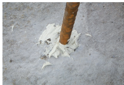
Fixieren von Verankerungen mit Methacrylat PCI Barrafix 920
