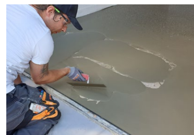
Einbau der zementären Beschichtung PCI Zemtec Outdoor in einer Garage
