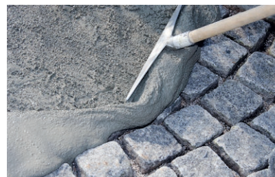
Einbringen des zementären Pflasterfugenmörtels PCI Pavifix CEM auf eine vorgenässte Pflasterstein- fläche
