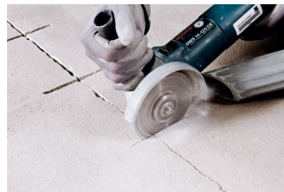
Estrich quer zur Arbeitsfuge einschneiden, aussaugen und PCI Estrichklammern einlegen
