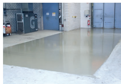
Ausgleich eines Betonbodens mit leicht verlaufendem Fließestrich PCI Zemtec 180
