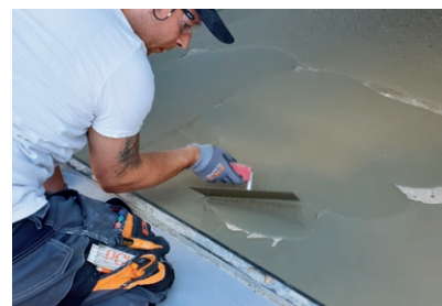
Und mit einer Rake in der gewünschten Schichtdicke verteilt
