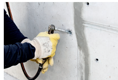
Den selbstdichtenden Packer in das zuvor gereinigte Bohrloch fest eindrehen
