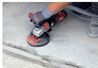
Alte Rückstände und Verunreinigungen durch Abschleifen entfernen
