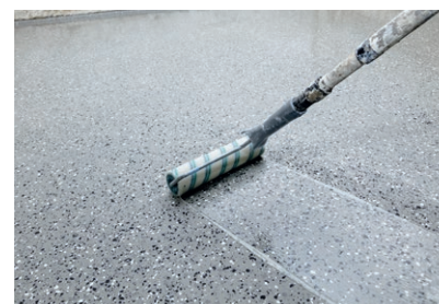
Optional Farbchips einstreuen und dekorativ gestaltete Fläche mit PCI Finopur lichtecht und seidenmatt versiegeln
