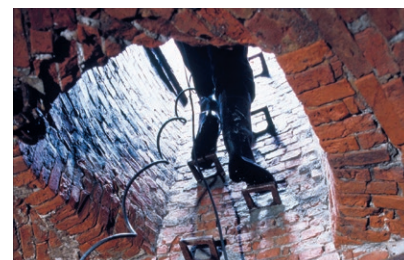
Setzen und Fixieren von Steigeisen im Bereich von Kanälen und Nachverfugen von Klinkerfugen mit PCI Polyfix plus L
