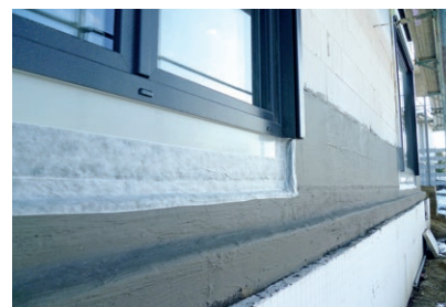
Geeignet auch als Sockel- und Putzabdichtung
