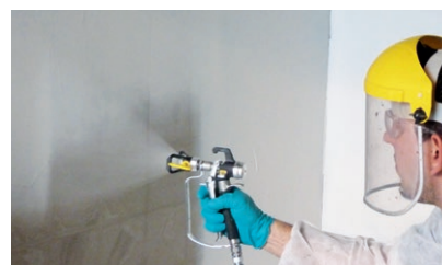
Maschineller Auftrag von PCI Polyflex zum rissüberbrückenden Schutz gegen Karbonatisierung einer Tiefgaragenwand aus Beton
