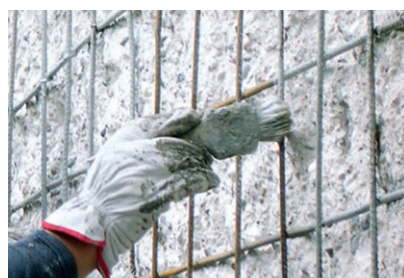
Vorbehandlung der Bewehrungsstäbe mit dem aktiv ausgestatteten Bewehrungsschutz PCI Nanocret AP
