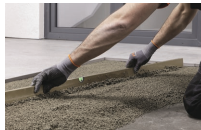
Abziehen des aufgetragenen Drainmörtels PCI Pavifix DM
