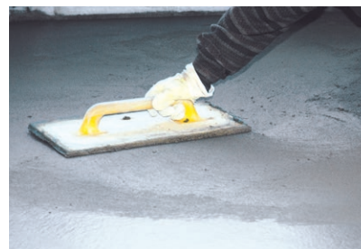
Gegebenenfalls ist unterhalb der Trennlage ein Ausgleich im Verbund aufzubringen
