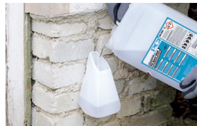
Mauerwerk mit der flüssigen Horizontalabdichtung PCI Barra Gisol gegen aufsteigende Feuchtigkeit schützen
