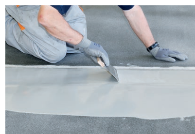
Händisches Anarbeiten an eine Dehnfuge
