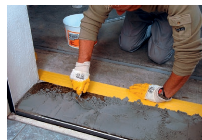
Ausgleich einer Schwelle oder Treppenstufe mit standfestem Epoxi-Mörtel PCI Aposan
