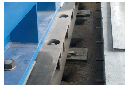
Schalung erstellen, Material gleichmäßig von einer Seite in die Schalung eingießen, damit Luft vollständig entweichen kann
