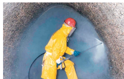
Vorbereiten einer geschädigten Betonoberfläche in einem Kanal
