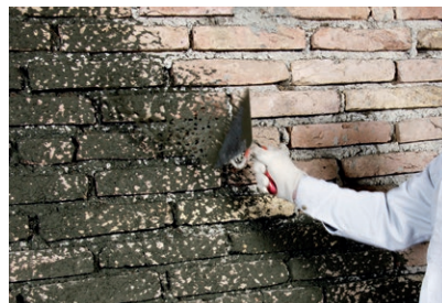
Aufbringen eines Spritzbewurfs, vergütet mit PCI Emulsion
