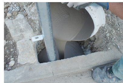
Fixieren von Einbauteilen mit zementärem PCI Repaflow Turbo
