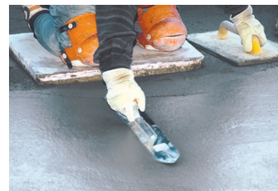
Estriche mit dem Glattschwert glätten
