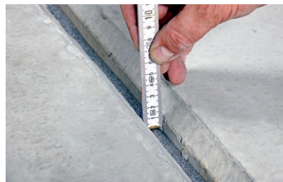
Auf die erforderliche Fugentiefe achten (mind. 10 mm)
