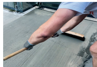
Ausführung eines Besenstrichs auf PCI Nanocret R4 PCC
