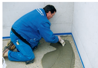
Bei Verbundestrichen ist eine Haftbrücke aus PCI Repahaft aufzubringen
