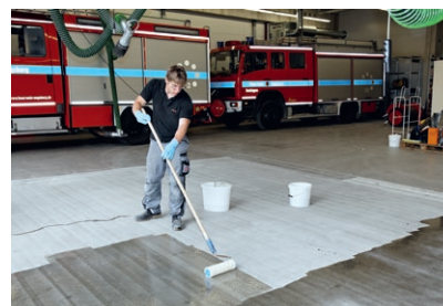
Grundieren der vorbereiteten Fläche mit Epoxidharz wie z. B. PCI Epoxigrund 390
