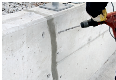
Bauteil schräg zum Rissverlauf abwechselnd rechts und links anbohren. Das Bohrloch muss den Riss etwa in der Mitte überschneiden
