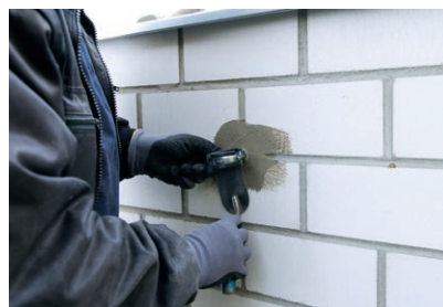
Verankern von Einbauteilen mithilfe von zementären Mörteln wie z.B. PCI Repafix
