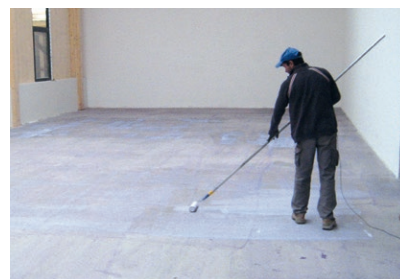
Vor dem Auftrag der fließfähigen Bodenausgleichsmasse PCI Gisogrund 404 als Haftvermittler aufbringen
