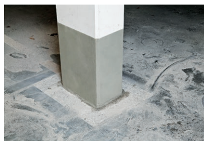
Mit dem Feinspachtel PCI Nanocret FC überarbeitete Stütze
