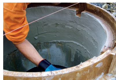
Auskleiden eines Schachtrings und Setzen mit PCI Polyfix plus L
