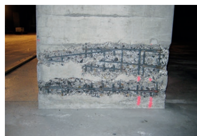
Freilegen eines mit Chlorid geschädigten Betons in einer Tiefgarage
