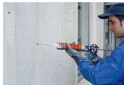
Verfüllen von Verankerungen mit Methacrylat PCI Barrafix 920
