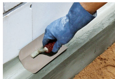
Scharfe Kanten brechen, Innenecken mit Reparaturmörtel PCI Nanocret R4 PCC/PCI Polyfix plus L als Dichtungs-/Hohlkehle ausbilden
