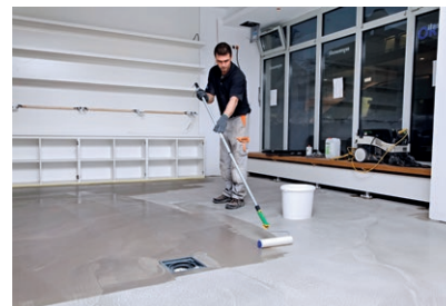
Nach ca. 1 Tag können die zementären Bodenausgleichsmassen mit einer Kopfversiegelung, z. B. PCI Zemtec Top, versiegelt werden
