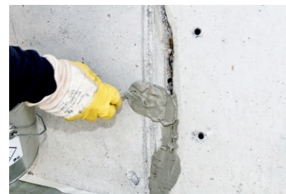
Risse und Klüfte sorgfältig mit Mörtel verschließen (ggf. zuvor aufweiten)
