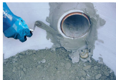
Setzen von Muffen mithilfe von zementären Mörteln wie z.B. PCI Repafix
