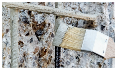
Den aktiv ausgestatteten Bewehrungsschutz PCI Nanocret AP in mindestens zwei Lagen volldeckend auftragen
