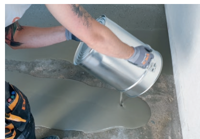
Die Bodenausgleichsmasse wird in Feldern auf den Boden aufgebracht
