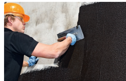
Die PCI Pecimor Bitumen-Dickbeschichtung lässt sich leicht und kraftsparend verarbeiten
