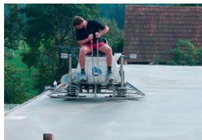
Estriche oberflächlich mit einem Flügelglätter glätten
