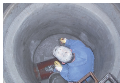
Aufbringen der mineralischen Dichtschlämme PCI Barraseal in einer Zisterne
