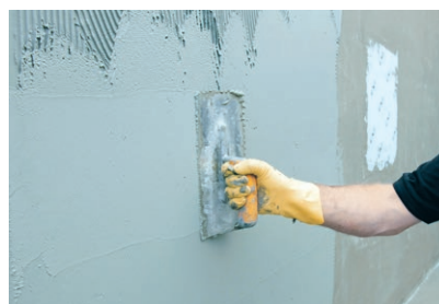
Aufbringen der schnell abbindenden, riss-überbrückenden und UV-beständigen Abdichtung PCI Barraseal Turbo in einem Wasserbecken
