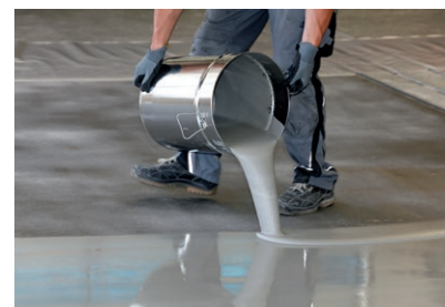
Aufbringen der Verlaufsbeschichtung
