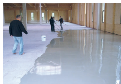
Einbau des mechanisch hoch belastbaren Zementbodenausgleichs PCI Periplan Multi in einer Gewerbehalle
