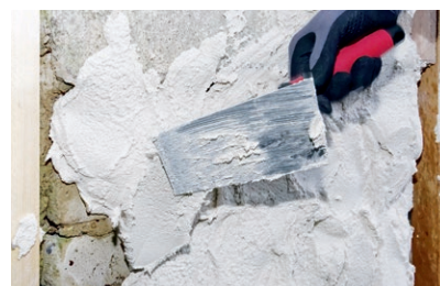
Aufbringen von PCI Saniment 2 in 1 als Sanierputz und Feinputz in einem
