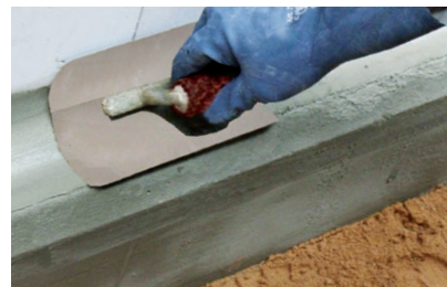
Ausbilden einer Dichtungs-/Hohlkehle am Übergang mit PCI Polyfix plus L
