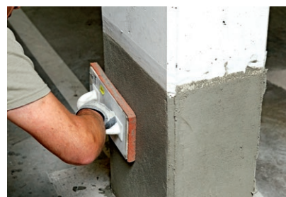
Schließen von Lunkern mit dem Feinspachtel PCI Nanocret FC
