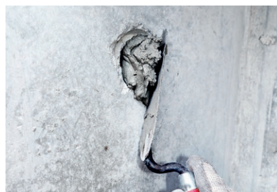
Schließen von Fehlstellen mit PCI Polyfix 5 Min. oder PCI Repafix
