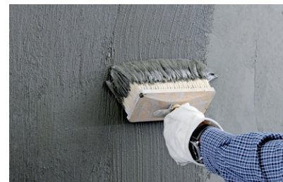
Aufbringen der mineralischen, sulfatbeständigen Abdichtung PCI Barraseal
