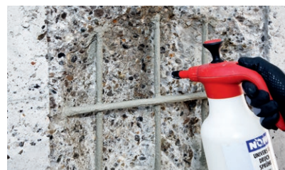
Vor der Betonsanierung Flächen mattfeucht vornässen, ggf. mit PCI Nanocret AP grundieren
