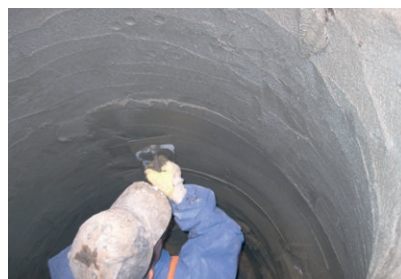
Herstellen eines ebenflächigen Untergrunds mit PCI Nanocret R4 PCC
