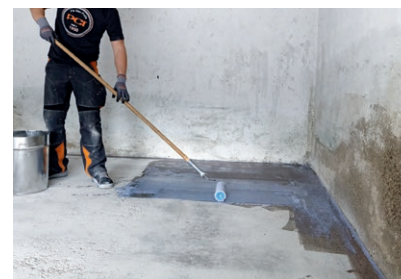
Zweimaliges Grundieren mit PCI Gisogrund 404 (im Kreuzgang sorgt für eine sichere Haftung des Bodenausgleichs auf dem Untergrund)
