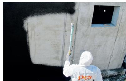
Grundierung eines saugfähigen Untergrunds mit PCI Pecimor F
