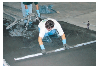
Estriche auf Dämm- und Trennlagen sind in homogenen Schichtdicken aufzubringen
