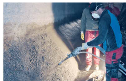
Der sulfatbeständige Reparaturmörtel PCI Nanocret R4 PCC kann sowohl händisch als auch maschinell aufgetragen werden
