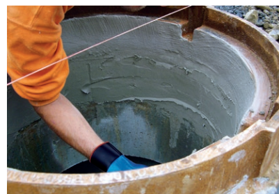
Anputzen und Setzen eines Schachtrings mit PCI Polyfix plus L
