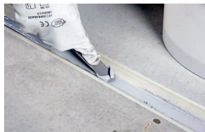
Abstreifen des überschüssigen Fugenmaterials und glätten
