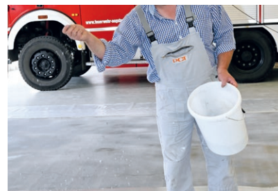
Einstreuen von Farbchips in die noch frische Beschichtung
