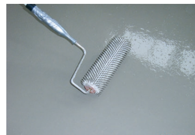
Das Material gleichmäßig verteilen und mit einer Stachelwalze entlüften
