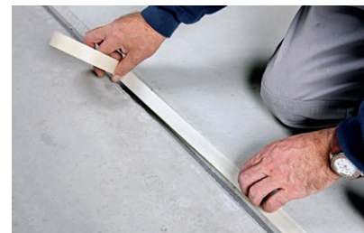
Abkleben der Fugenkanten
