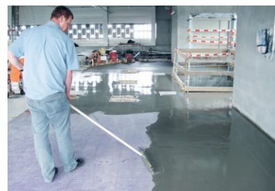
Nach 3 Stunden kann ein Bodenausgleich, z. B. mit PCI Zemtec 1K, homogen aufgetragen werden
