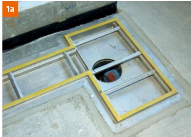
1a Einbauteile, Abläufe, Durchdringungen, Rinnen und Schwallmulden werden in die Flächenabdichtung eingebunden.
