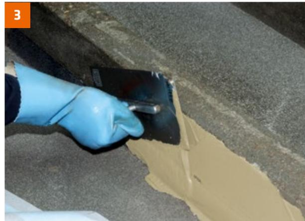
3 Vor dem Verkleben der Abdichtbänder wird PCI Apoflex vorgelegt.
