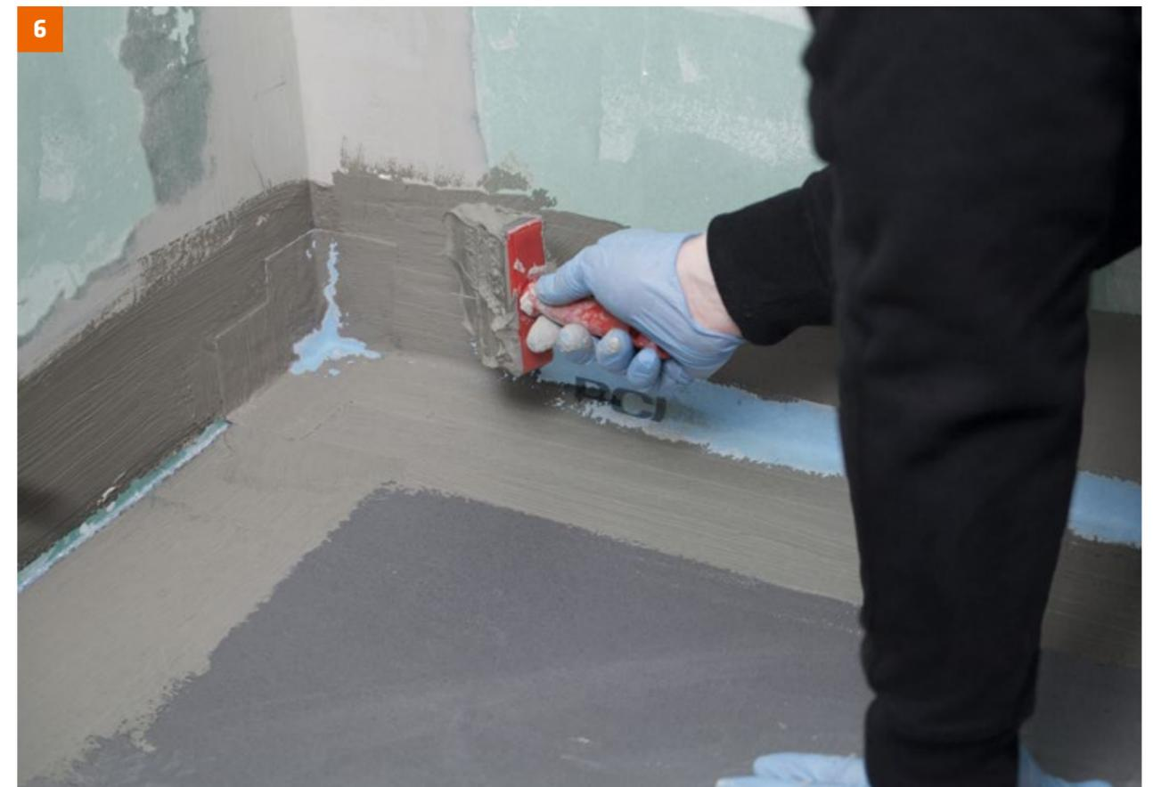
... und die vlieskaschierten Bereiche mit PCI Seccoral 1K / 2K Rapid überstreichen.
