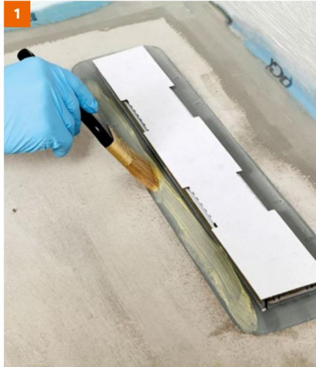
1 Grundierung des Anschlussflansches mit PCI Epoxigrund 390.
