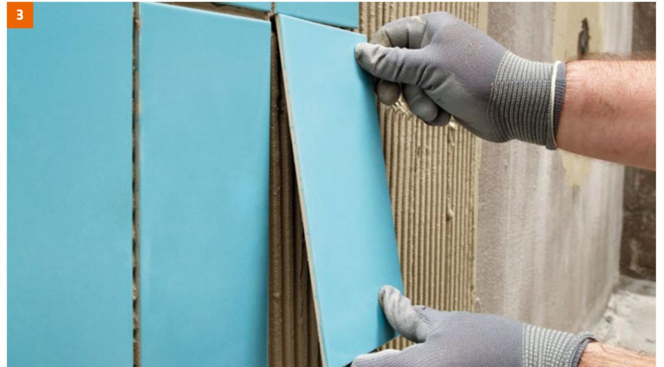
... und die Fliesen ansetzen und ausrichten. Buttering-Floating-Verfahren erforderlich.
