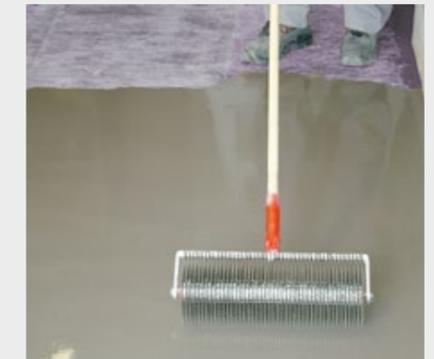
... und mit einer geeigneten Stachelwalze entlüften.
