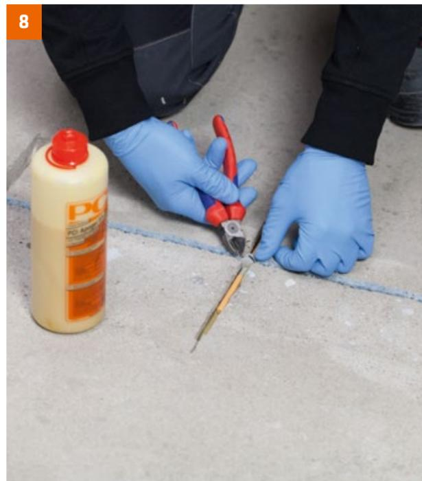
PCI Apogel Dübel in die Nut einlegen und den Spannring entfernen.
