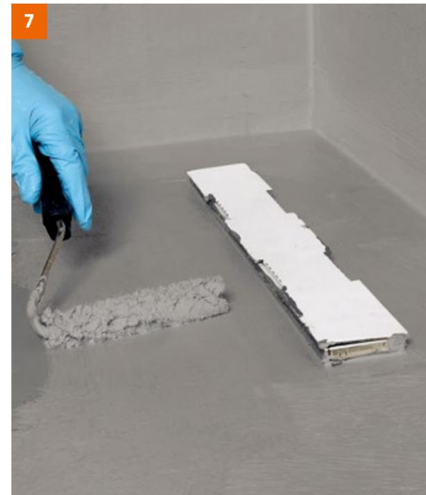
7 Nach einer Wartezeit von ca. 1 Stunde erfolgt jeweils nächste Auflag bis zum Erlangen der Mindesttrockenschichtdicke von 2 mm.
