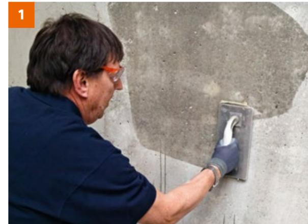
Das gründliche Vornässen reduziert die Saugfähigkeit des Betons und verhindert, dass der nachfolgenden Abdichtung zu schnell das Wasser entzogen wird.
