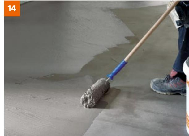
14 PCI Seccoral 2K Rapid kann auch – bis zum Erreichen der erforderlichen Trockenschichtdicke von 2 mm – mittels Lammfellrolle aufgetragen werden.
