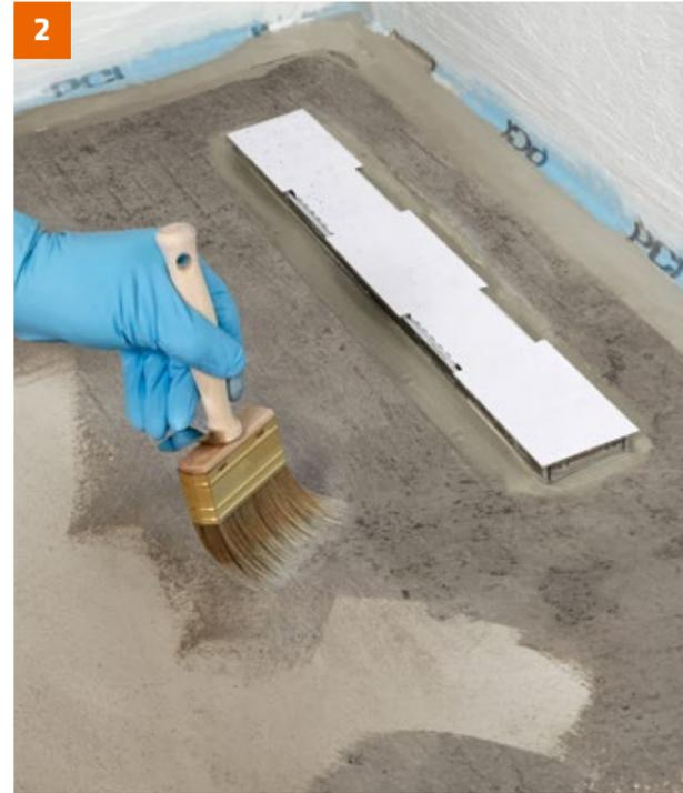
2 Die übrige Bodenfläche wird vorgehäst und mit verdünntem PCI Seccoral 1K / 2K Rapid grundiert.
