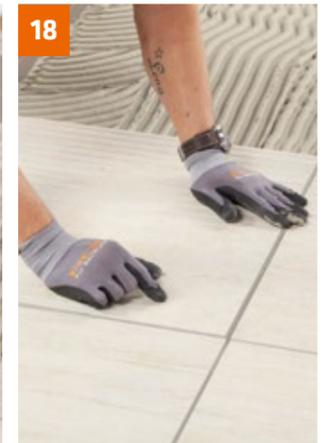
18 ... einschieben und ggf. mittels Gummihammer einklopfen. Danach ausrichten.
