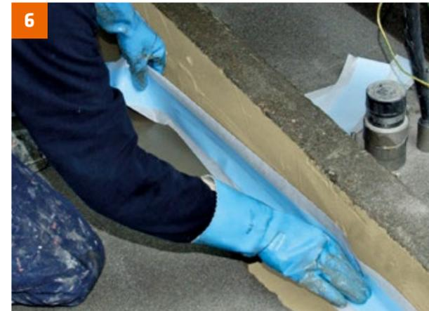
6 Danach wird zum Beispiel PCI Pecitape 120 oder PCI Pecitape Objekt eingelegt und übergearbeitet.
