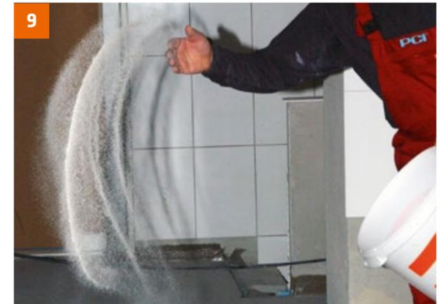
9 Zur besseren mechanischen Verkrallung mit dem Fliesenkleber, die 2K-Polyurethan-Abdichtung PCI Apoflex vollsatt mit Quarzsand abstreuen.
