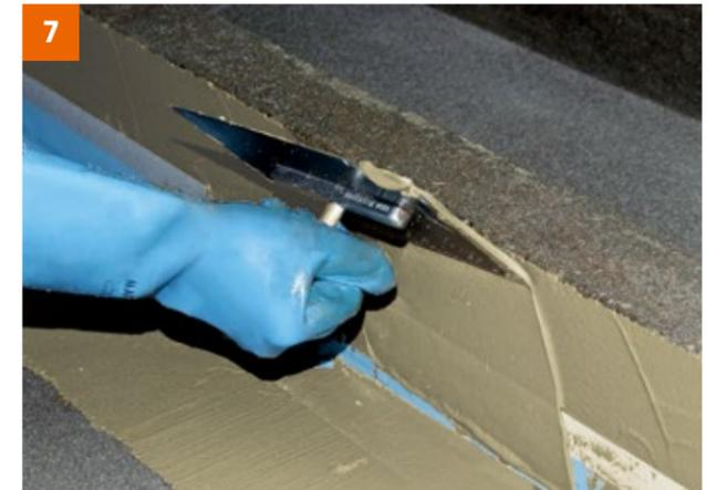
7 Anschließend noch einmal mit PCI Apoflex überarbeiten.
