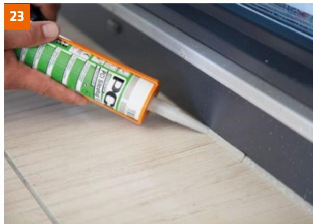
Silikonieren mit PCI Silcofug E oder PCI Silcoform S im Anschlussbereich zum Kunststofffenster.
