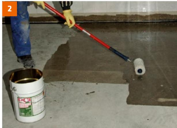
2 Untergründe vorbereiten, Verunreinigungen und nicht tragfähige Bereiche entfernen und ausgleichen. Mit PCI Epoxigrund 390 grundieren.
