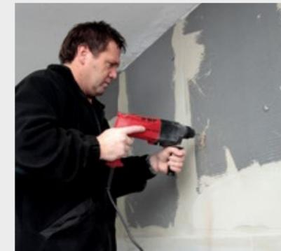
Nach Härtung des Klebemörtels werden die Bohrungen für die Dübel (ca. 5 Stck./m<sup>2</sup>) gesetzt.
