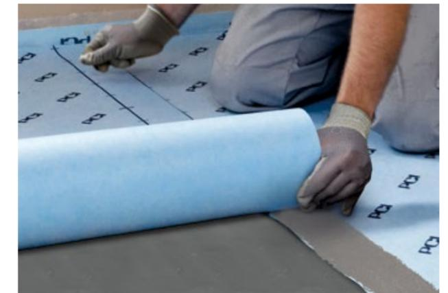
Die Stöße der Abdichtungsbahn PCI Pecilastic W müssen ca. 5 bis 10 cm überlappen. Die Überlappung der Bahnen mit dem Spezialkleber PCI Pecilastic W-Lim einstreichen und innerhalb der klebeoffenen Zeit die folgende Bahn einlegen und sorgfältig andrücken.
