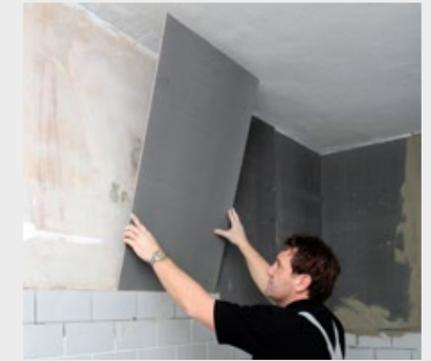
PCI PowerBoard-Element ansetzen und anschließend anklopfen.
