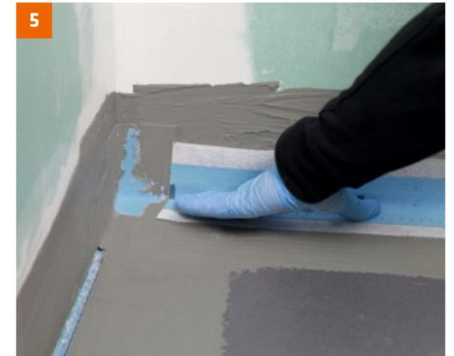
Dichtband PCI Pecitape 120 überlappend mit der Dichtecke einlegen...
