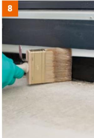
8 Element grundieren mit PCI Epoxigrund 390 ...
