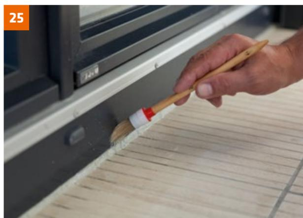
Zum leichteren Abziehen der Silikonfuge zum Beispiel PCI Glättmittel auftragen ...
