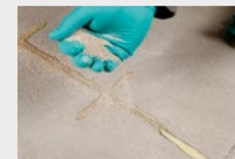
Angemischtes Gießharz in die Risse/Fugen oberflächenbündig eingießen, glatt abziehen und mit trockenem Quarzsand abstreuen.
