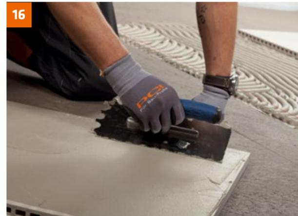
16 Kratzspachtelung mit PCI Nanorapid auf der Fliesenrückseite aufziehen ...
