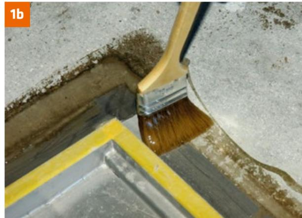
1b Details und Übergänge an Einbauteilen sowie Durchdringungen mit PCI Epoxigrund 390 grundieren.
