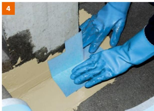
4 Formteil PCI Pecitape 90° in die Abdichtungsschicht einlegen ...
