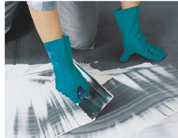
Mit dem verformungsfähigen Reaktionsharz-Fliesenkleber PCI Collastic ...
