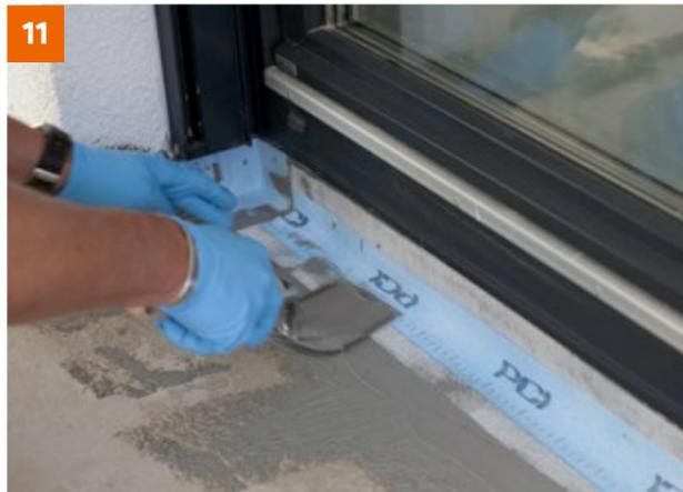
11 PCI Pectape 120 in PCI Seccoral 2K Rapid einlegen.
