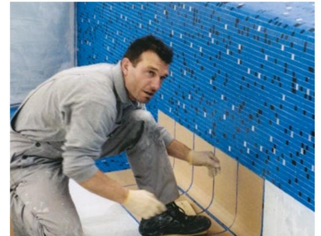
... werden keramische Beläge sicher auf Stahlkonstruktionen verlegt.
