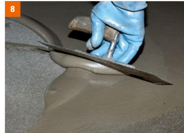
8 PCI Apoflex in der Wand- oder Bodenvariante als Verbundabdichtung in zwei Arbeitsgängen auftragen.
