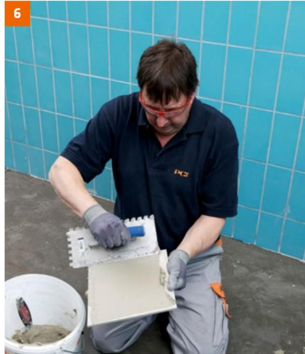
... wird das Buttering-Floating-Verfahren angewendet.
