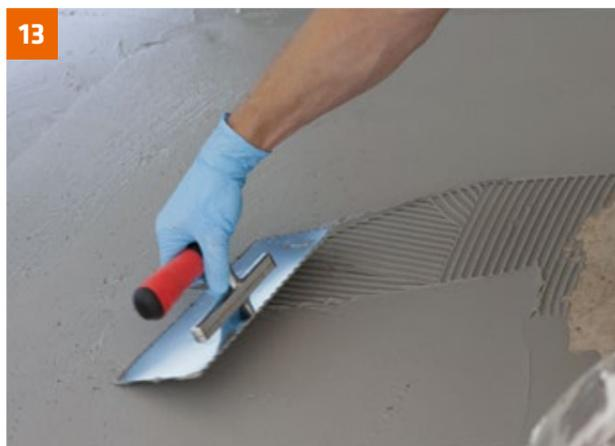
13 PCI Seccoral 2K Rapid mit 6er Zahnung aufkämmen und anschließend glattstreichen; nach ausreichender Trocknung der ersten Schicht den zweiten Auftrag in gleicher Weise vornehmen.
