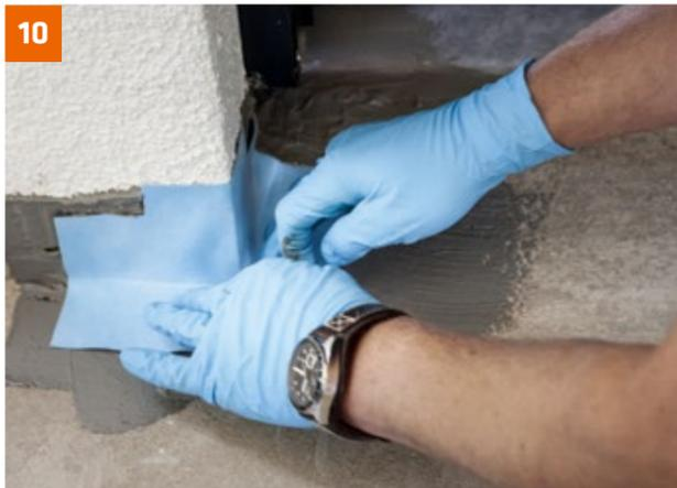
10 Detail Wandanschluss: PCI Seccoral 2K Rapid vorlegen und Außenecke einlegen.
