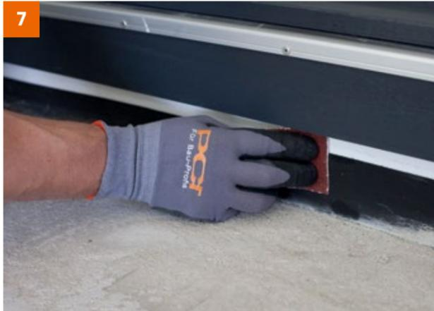
7 Detail Türabdichtung mit PCI Pectape 120 / Objekt: Element anschleifen und anschließend reinigen mit PCI Univerdünner.
