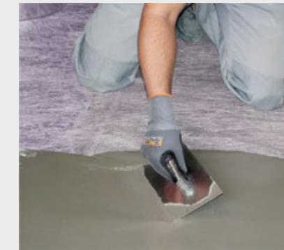
Mit einer Glättkelle oder Kufenrakel verteilen (keine Stiftrakel verwenden!)
