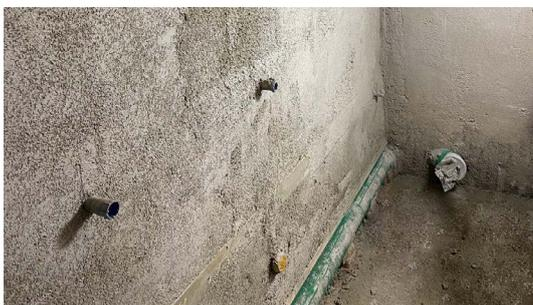
Mit FM 388 Light fertig verputzte Wand vor dem Aufbringen der Gewebespachtelung mit codeX UX 410 und einem codeX Dünnbettmörtel
