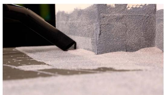
Durch Absandung ist eine zementäre Verlegung mit codex Power RX 11 Outdoor möglich, ohne Absandung mit codex Fliesapur
