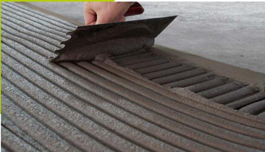
Mit der Glättkelle eine dünne, geschlossene Kontaktschicht auf den Untergrund aufkratzen, frischen Mörtel nachlegen und mit Zahntraufel gleichmäßig aufkämmen
