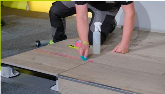
Verfugen von Terrassenplatten verlegt mit codex BalkuLift
