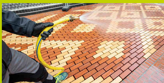
Alle Belagselemente gut vornässen
