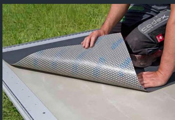
2. Bahn lose auslegen
