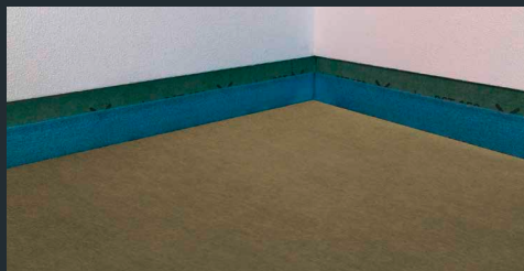
Abdichtung aufbringen inkl. Dichtbänder anschließend Randdämmstreifen anbringen
