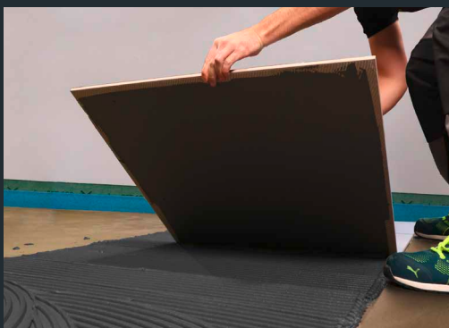
3. Im Außenbereich Buttering-Floating-Verfahren anwenden
