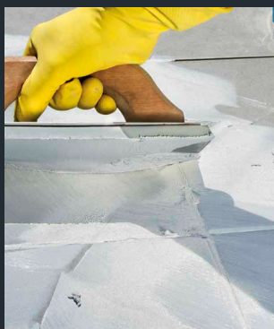
5. Nach Begehbarkeit mit codex X-Fusion verfugen*
