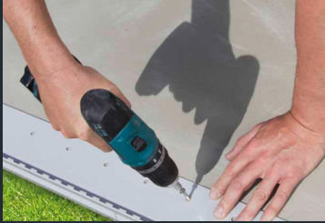
1. Geeignete Abschlussprofile anbringen
