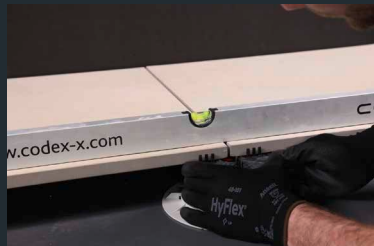
8. Verlegen der weiteren Platten und Feinjustierung am Drehteller
