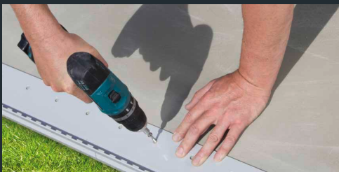
1. Geeignete Abschlussprofile anbringen
