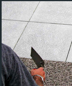
5. Belag im Buttering-Verfahren verlegen und mit codex X-Fusion verfugen*
