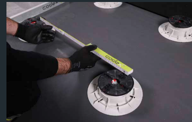
6. Ausrichten der weiteren codex BL Tower auf Abstand und Höhe
