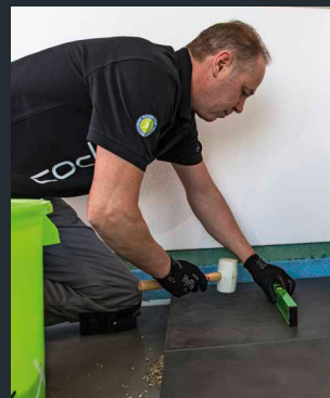
5. Platten platzieren und ausrichten. Im gleichen Raster weiterarbeiten. Fugenbreite mind. 3 mm*
