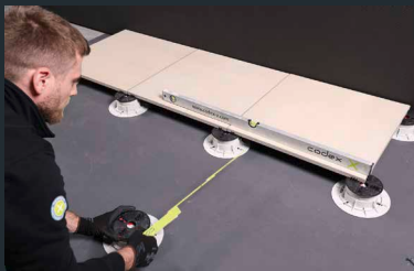
10. Feinjustierung mit Montageschlüssel codex BL Key
