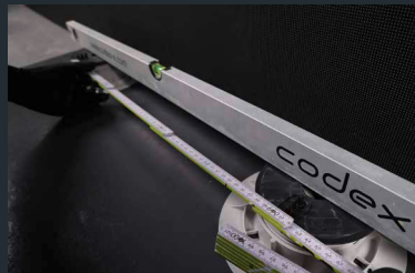
5. Ausrichten der ersten Reihe codex BL Tower auf Abstand und Höhe
