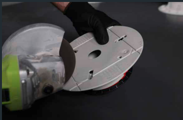
4. Zuschnitt der Stelzlager zum anlegen der ersten Reihe
