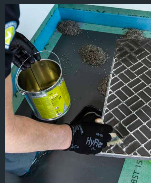
4. Je nach Plattendicke/-größe Belag auf 4 - 6 Batzen verlegen
