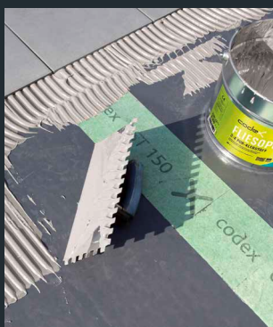
4. Fliesen mit codex Fliesopur verlegen
