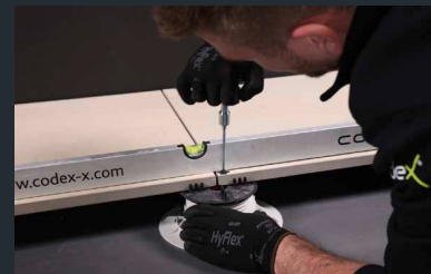
9. Verlegen und Ausrichten der zweiten Fliesenreihe
