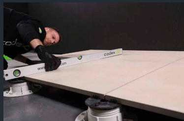
11. Ausrichten der codex BL Tower für die zweite Reihe
