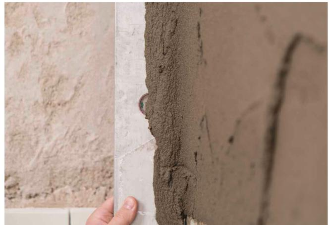
Mit der Richtlatte Oberfläche eben bzw. im erforderlichen Gefälle abziehen.
