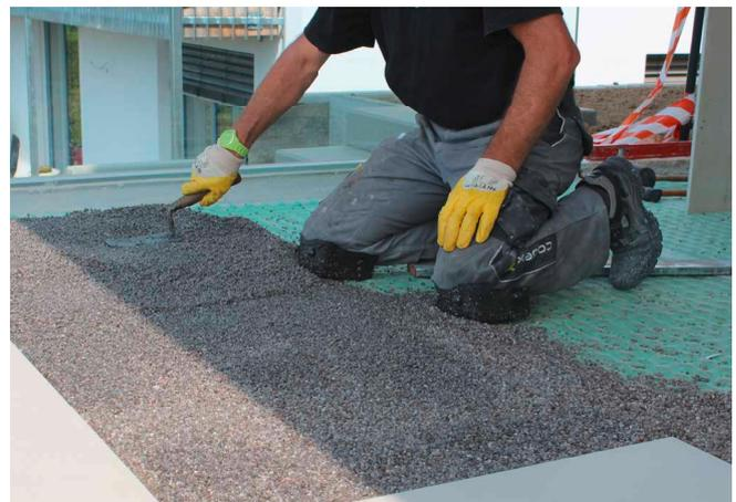
Verlegung in Batzentechnik mit Epoxi-Mörtel aus codex ER 100 und DS 3/5.
