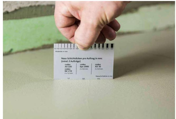
2. Kontaktschicht aufziehen und anschließend erste Schicht mit 4 mm Zählung aufkämmen und glatt umlegen. Nach Trocknung zweite Schicht auftragen.
