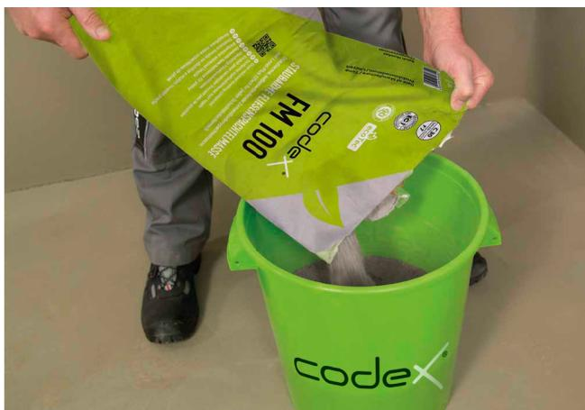
Staubarme, selbstverlaufende Zement-Bodenspachtelmasse codex FM 100 in den mit der angegebenen Wassermenge gefüllten Anrührer schütten und anrühren.
