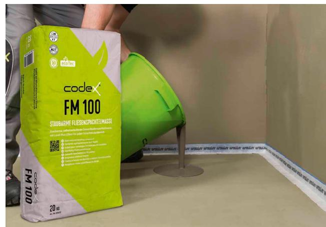
Fliesenspachtelmasse auf den Untergrund gießen und mit der Glättkelle oder dem Großflächenraket gleichmäßig verteilen.
