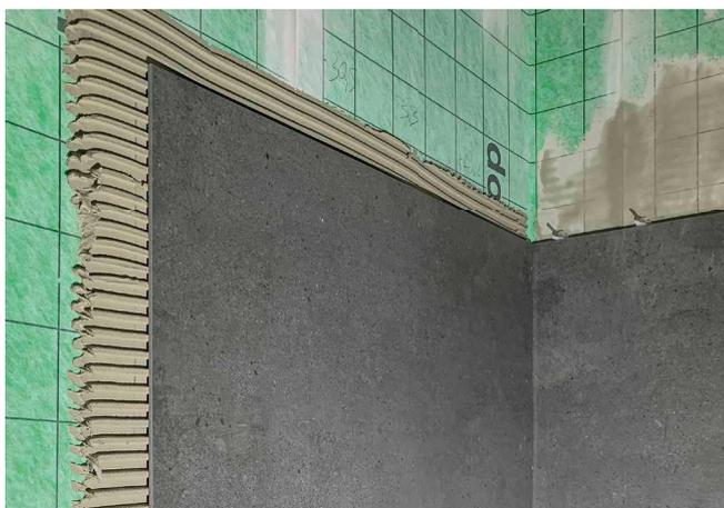
Leichtes Auftragen des codex POWER CX 7 auf Wand- und Bodenflächen durch variabel einstellbare Konsistenz.
