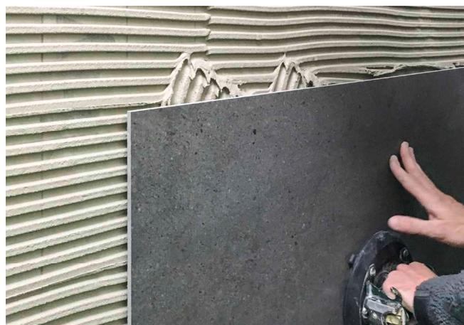
Einfache Verlegung von großformatigen Fliesen an der Wand dank extremer Standfestigkeit.
